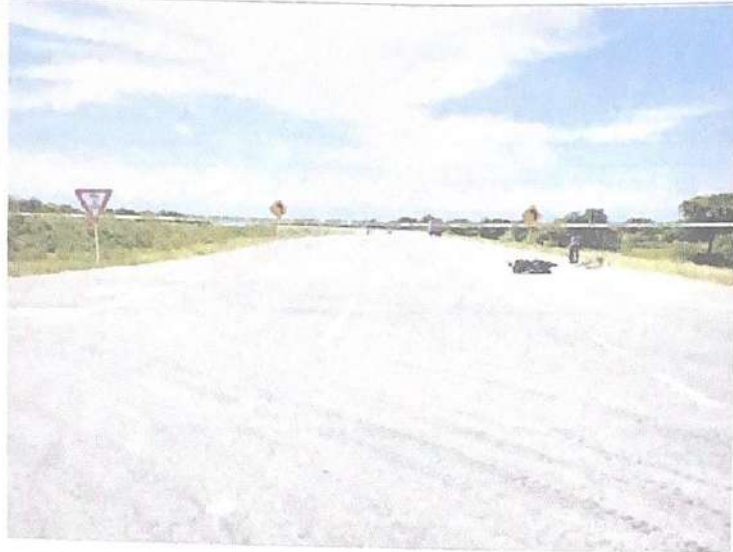
FOTOGRAFÍA No. 01 PLANO GENERAL: ESTA IMAGEN PERMITE OBSERVAR EL LUGAR DONDE SUCEDIERON LOS HECHOS UBICADO EN LA VIA PUEBLO NUEVO - VALLEDUPAR KILOMETRO 1 VARIANTE DE AGUAS BLANCAS A LA ALTURA DEL KILOMETRO 01, DONDE SE OBSERVA EL ESTADO DE LA VIA, SU DEMARCACION.
